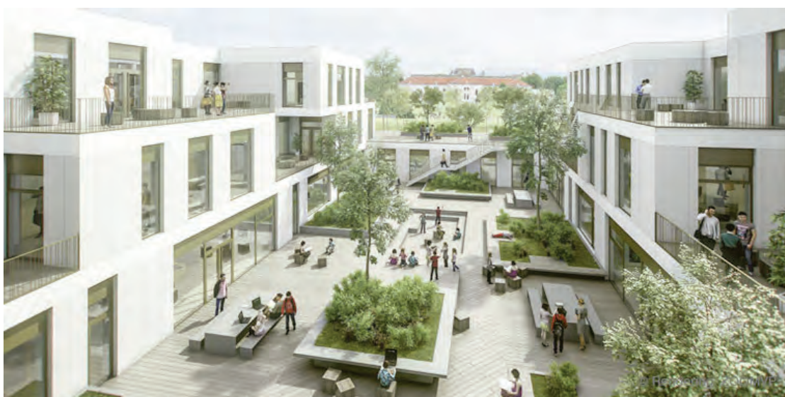
Aktuell entsteht die Schule "AHS-WienWest" im 14. Wiener Gemeindebezirk in der Steinbruchstrasse 33 auf dem Gelände der ehemaligen Biedermann-Huth-Raschke-Kaserne.
